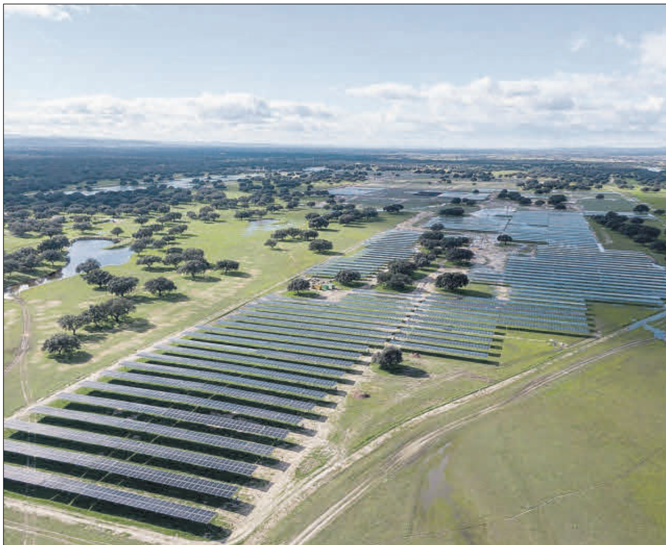
Planta fotovoltaica. EP
